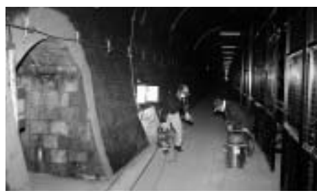
J R中央線の旧大日影トンネルと旧深沢トンネルが町へ払下げられ、契約を交わした
